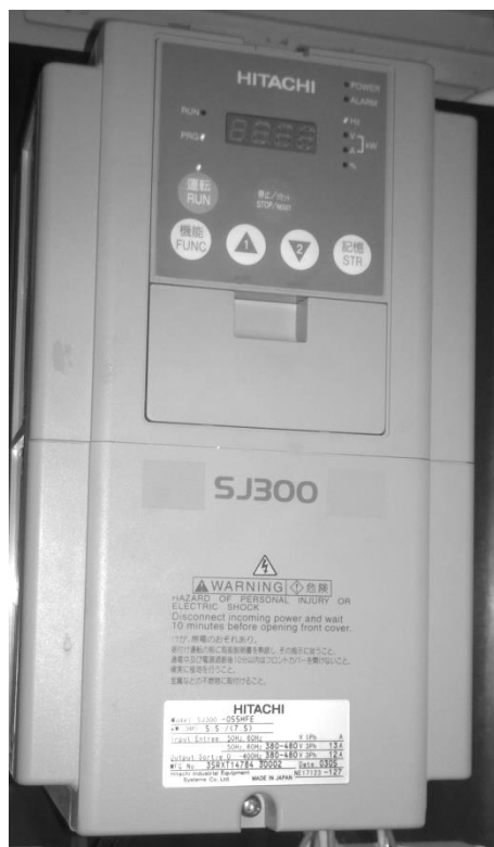
Rys.3. Panel przedni falownika SJ300 firmy HITACHI
